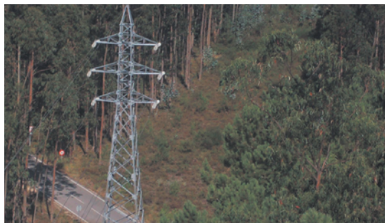
Вид с вертолета на 60 кВ воздушную линию электропередач, пересекающую сильно залесенную местность
